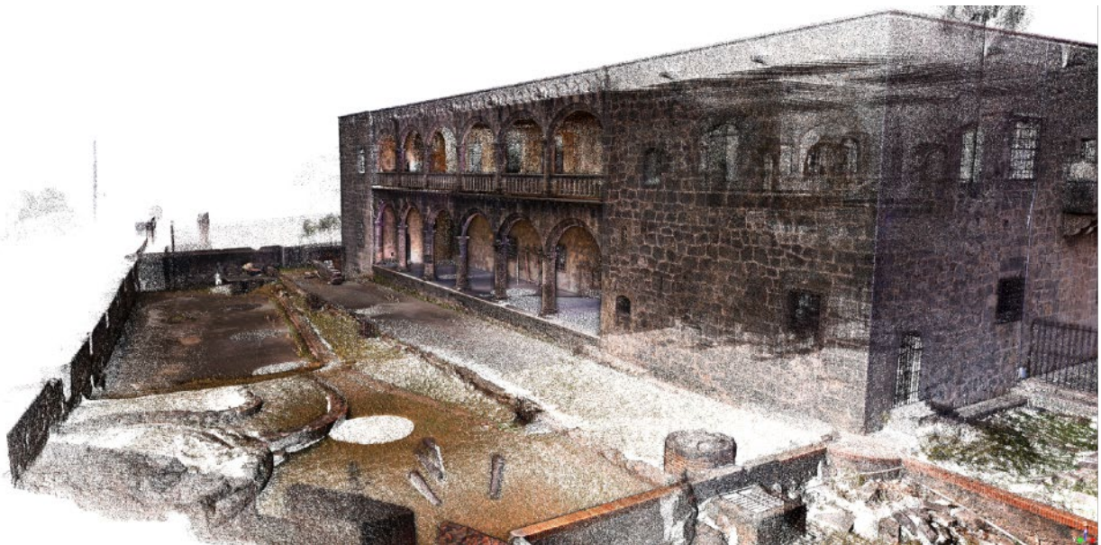
Nube de puntos_ Alcazar de Colón fachada Este
