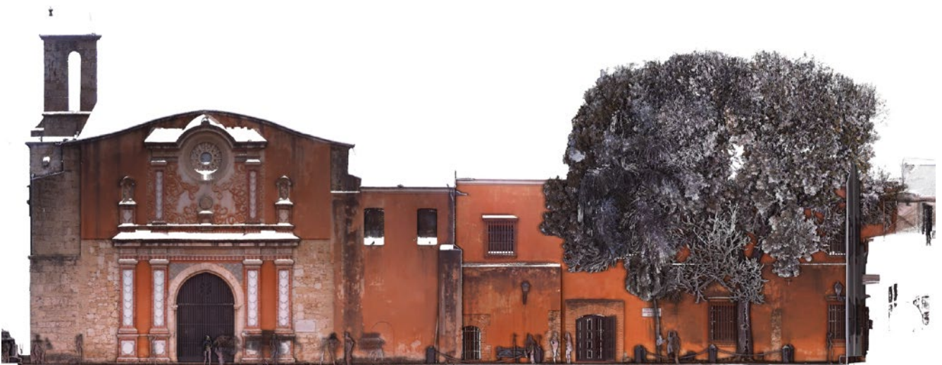
Ortofoto_ Iglesia Convento de los Dominicos_ Frontal
